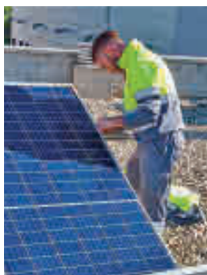
Instalación de placas solares
